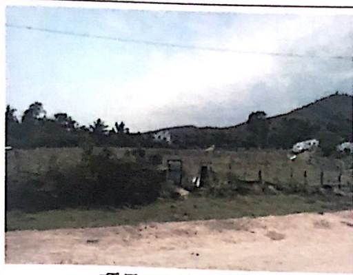
项目 P1 地块现状
