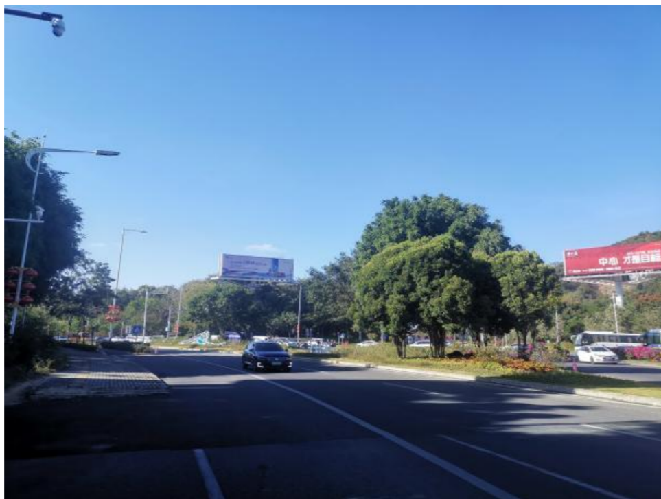
南侧导流岛现状
